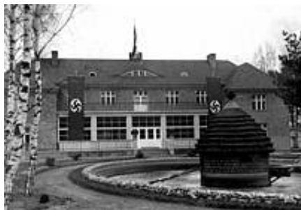
Budynek Komendantury w obozie Stutthof, 1941 r. Fot. ze zbiorów Archiwum Muzeum Stutthof
